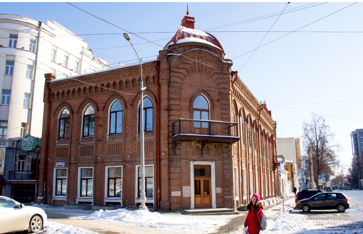
ул. Розы Люксембург 1
