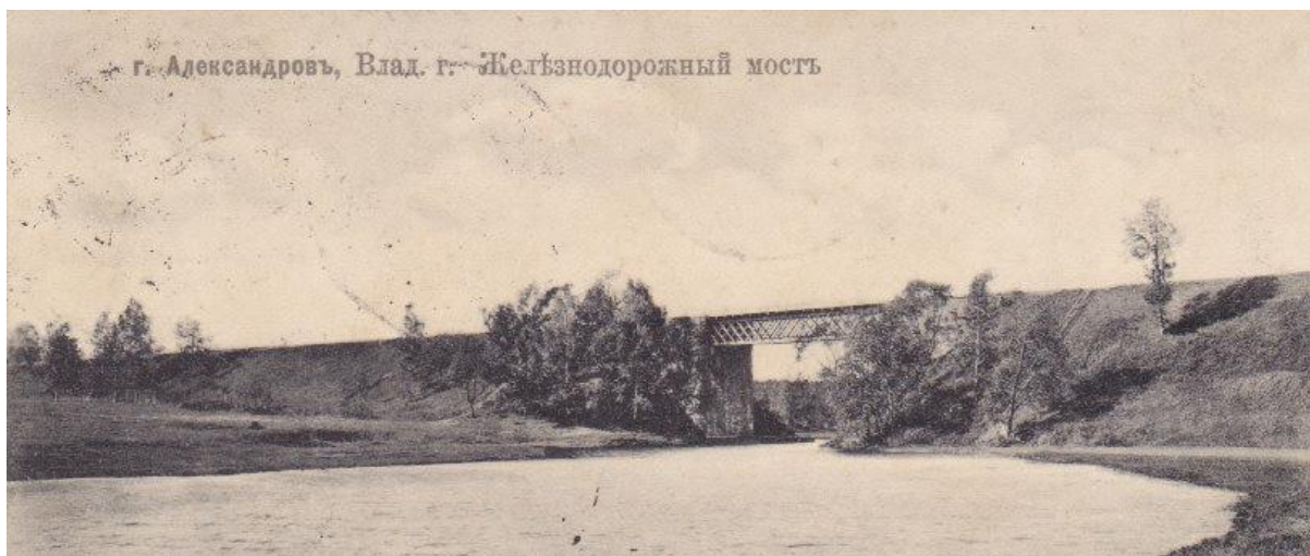
Приложение 4. Металлический мост с каменными опорами.
