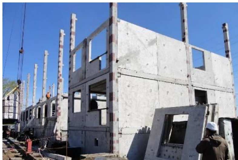
Рисунок 7. Пенобетонные панели.
