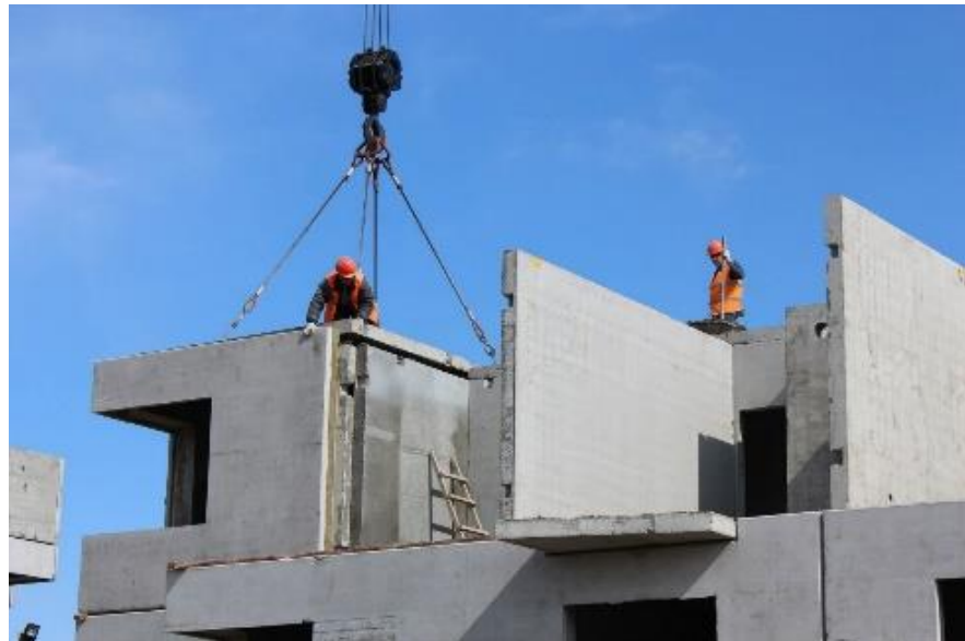
Рисунок 8. Объемно-блочные плиты.
