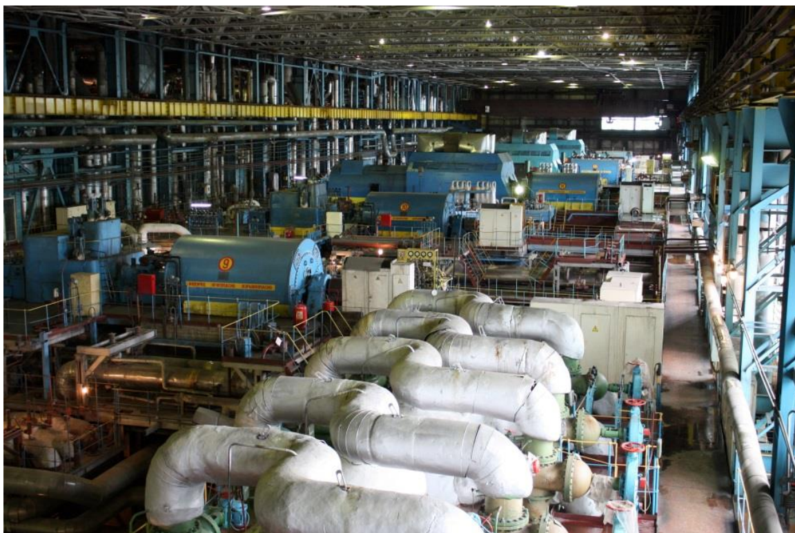
Турбинный цех Кемеровской ГРЭС
