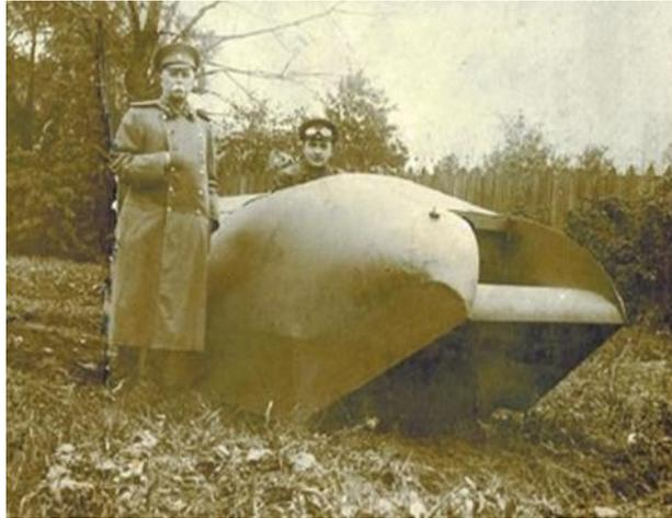
Идея создать такую машину возникла у А.А. Пороховщикова в 1914 году, когда он видел солдат, бегущих под пулеметным огнем врага. В голову конструктору пришла мысль, что штурмовать окопы врага лучше не людям, беззащитным против свинцового ливня, а боевой машине, которая будет «одета» в броню и снабжена пулеметом.
