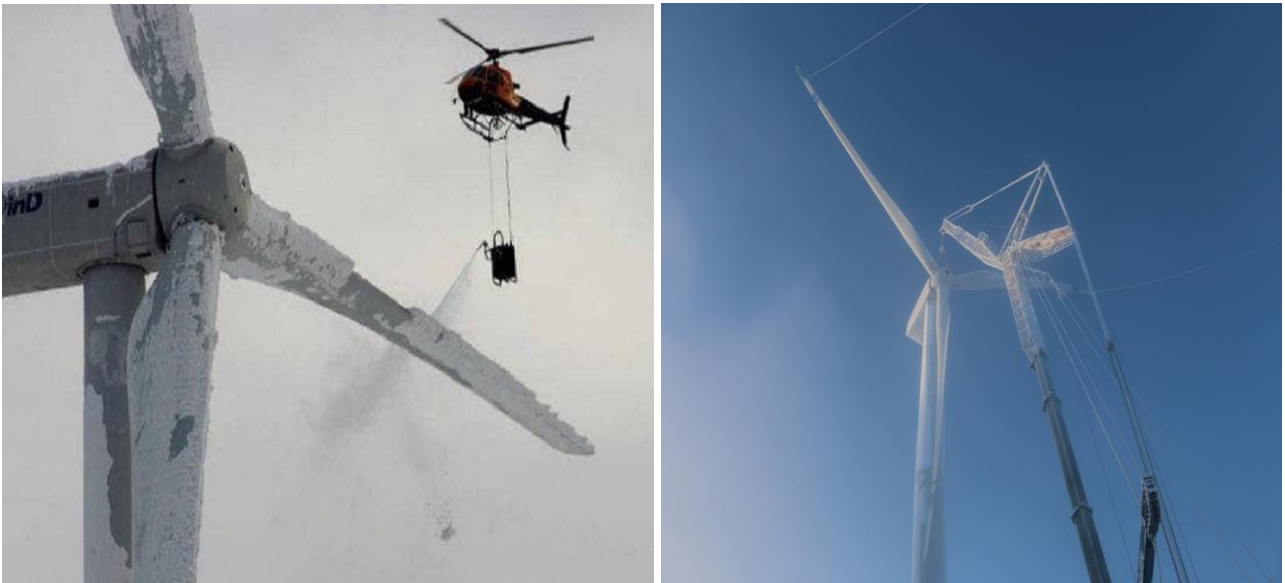
Рис. 2 Обледенение лопастей и других частей ветрогенератора, удаление наледи механическим путем
