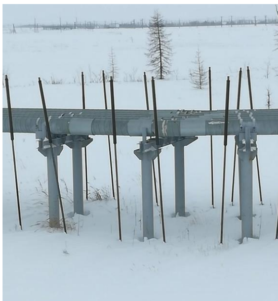
Фото 2,3. Устройства искусственного охлаждения грунта.
