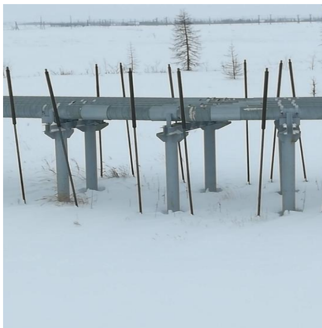
Фото 7. Устройство искусственного охлаждения грунта промышленного назначения.
