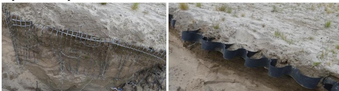
Фото 11,12. Разрушенные георешётки на лыжной трассе.
