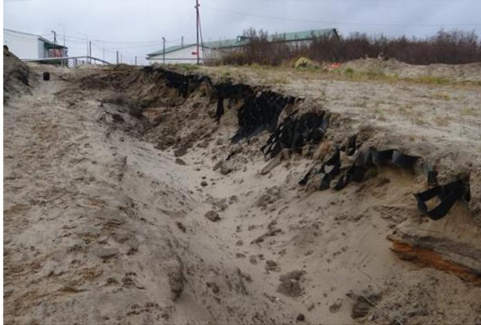
Фото 4. Размыв грунта водной эрозией в результате таяния мерзлоты на большом уклоне лыжной трассы п. Тазовский.
