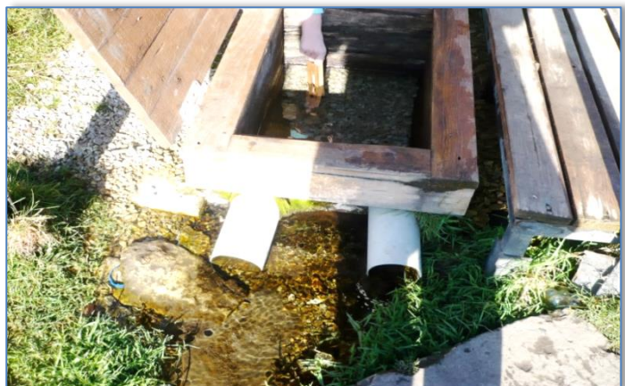
Фото 4. Прямоугольное деревянное оформление колодца с крышкой и пластиковыми трубами в стенке захаровского колодца (объект К2)
