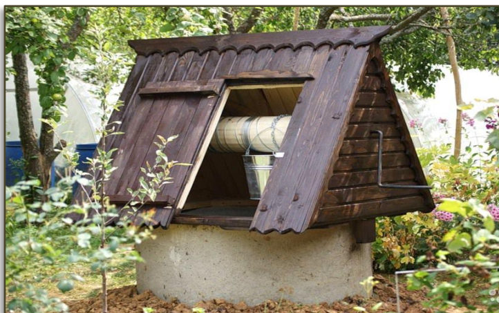
Фото 7. Бетонный колодец в левобережной пойме р. Соловы в д. Захаровке (объект К4)
