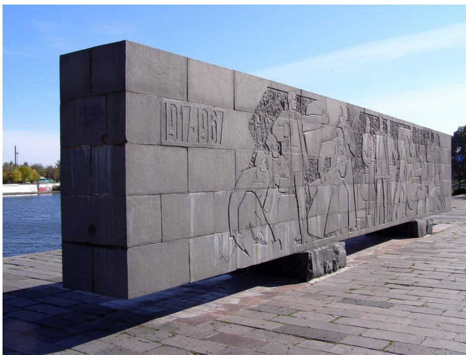
Рис. 3. Западная сторона стелы до реконструкции, 23.07.2011 г. (фотография сайта «ЕСОСЕДИ»)
