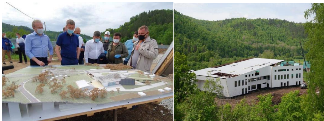
Рис. 13 Процесс строительства комплекса
