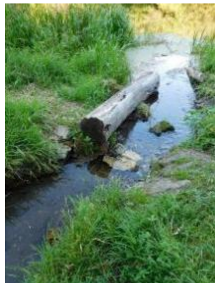
Рис. 11 Водоотводная канавка, август 2019 г.
