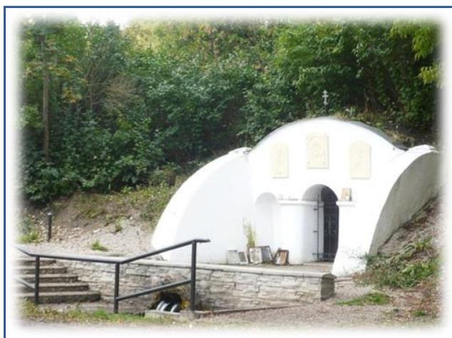
Родник хорошо обустроен: подземные воды поступают наружу по металлической трубе диаметром 10 см, которая заключена в керамическую трубу длиной 3,0 м. Расход воды – 0,5 л/сек. Вода в колодце без запаха, прозрачная (прозрачность 60 см), приятная на вкус. Температура воды в
