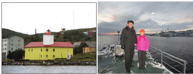
Башня береговой радиолокационной станции
