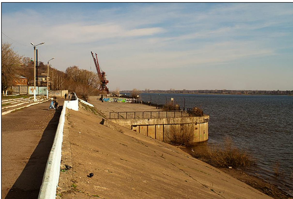
Рисунок Д.1-Набережная реки Кама до реконструкции
