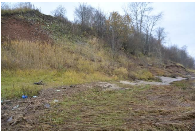
Фото 12. Общий вид склона
