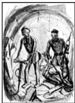
Давид Олер работает в туннеле. 1947г.
